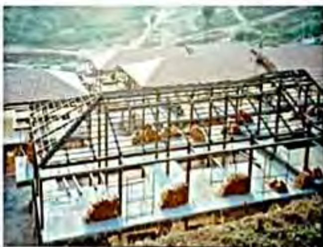
VISTA GERAL DA ESTRUTURA
