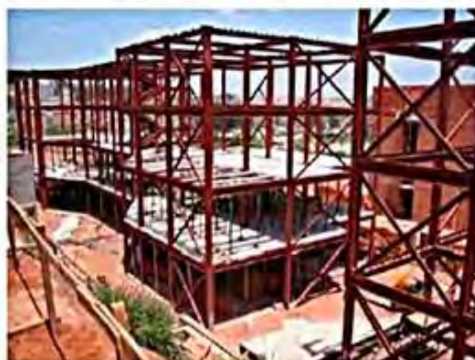
EXECUÇÃO DA LAJE
