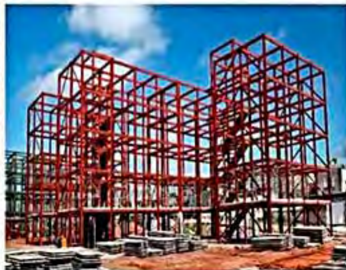
MONTAGEM DA ESTRUTURA
