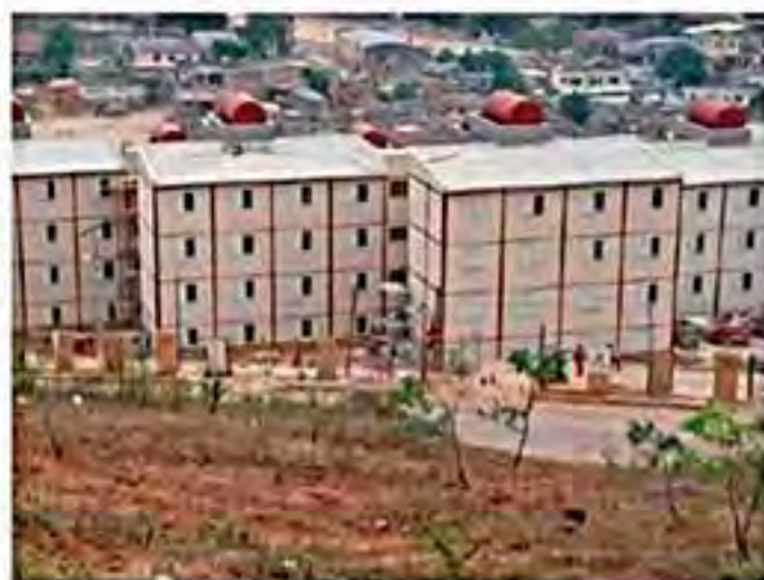
EDIFICAÇÃO DE 4 PAVIMENTOS
